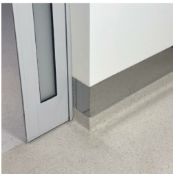
Приклад влаштування плінтуса з лінолеуму та відбійника з нержавіючої сталі
