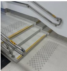
Приклад встановлення тактильних індикаторів та контрастного маркування
