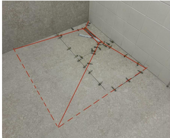
Приклад влаштування "конвертів" з плитки у зоні підлогового душевого трапу
