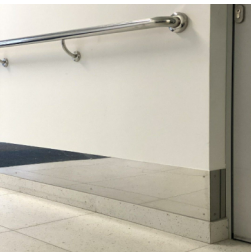
Приклад влаштування плінтуса з керамограніту та відбійника з нержавіючої сталі
