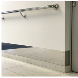
Приклад вштовпування плінтуса з керамограніту та відбійника з нержавіючої сталі
