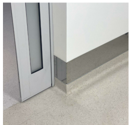
Приклад влаштування плінтуса з лінолеуму та відбійника з нержавіючої сталі
