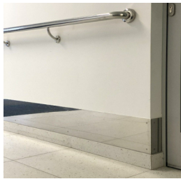
Приклад владштування плінтусу з керамограніту та відбійника з нержавіючої сталі
