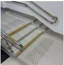
Приклад вштовпування тактильних індикаторів та контрастного маркування
