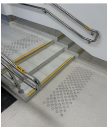
Приклад владштування тактильних індикаторів та контрастного маркування
